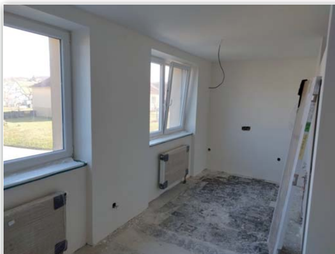
Probíhající rekonstrukce bytu na ul. Školní 491
