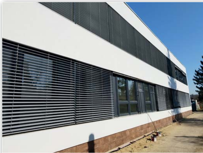
Jižní strana fasády ZŠ před dokončením
