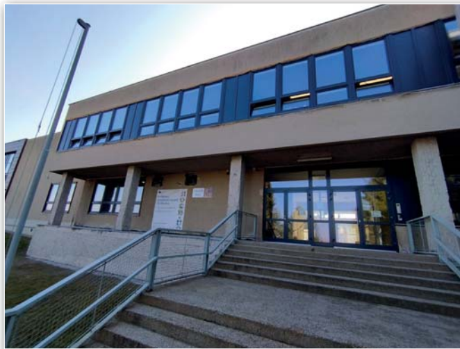
Postup prací na zateplení ZŠ
