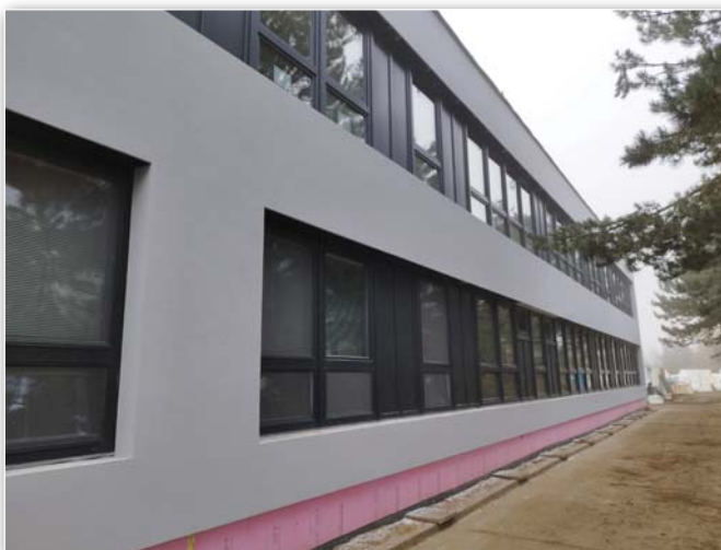
Téměř dokončená část zateplené fasády ZŠ
