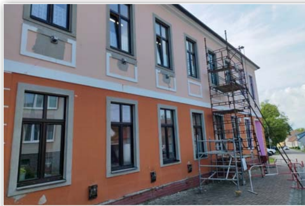
Oprava špalet u oken na staré škole
