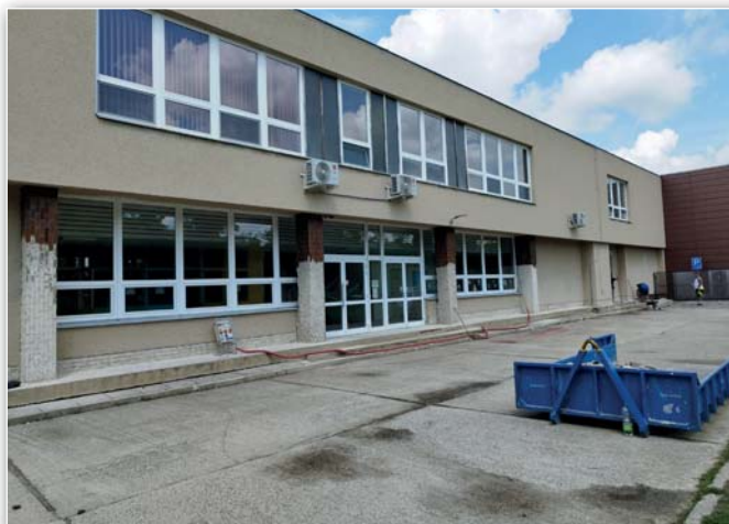
Zahájení prací na zateplení základní školy
