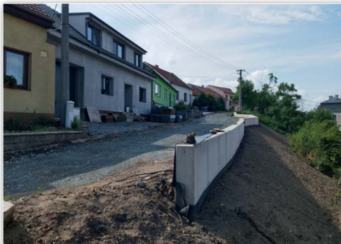
Průběh stavebních prací v ul. Na Kopečku
