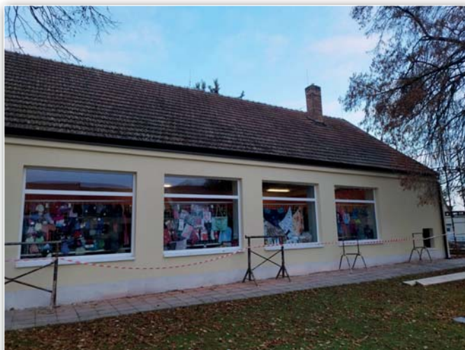
Zateplení a fasáda na budově textilu, stav před dokončením
