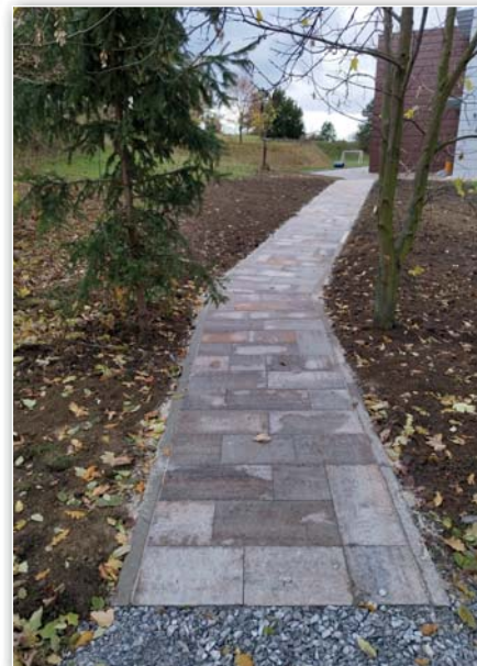
Nově vybudovaný chodník v areálu ZŠ
