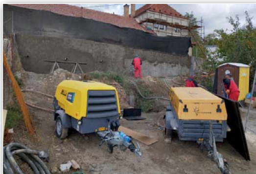
Výstavba opěrné zdi na ul. Horní 1
