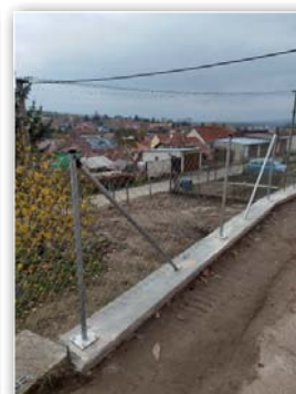
Výstavba opěrné zdi na ul. Horní
