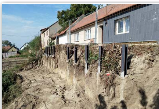
Výstavba opěrné zdi na ul. Horní 3
