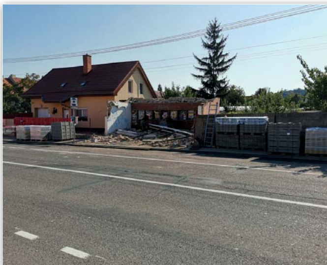
stavba nové autobusové čekárny
