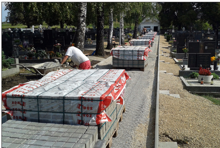
Oprava cesty na hřbitově.
