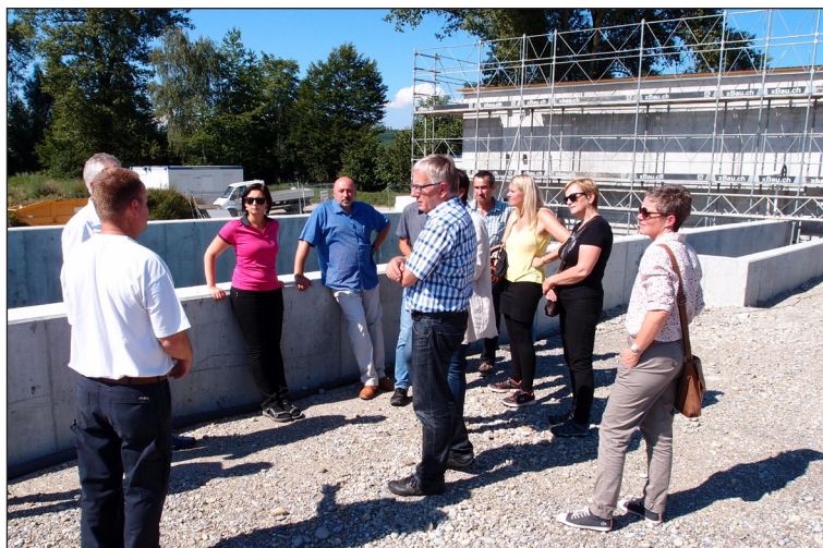
Prohlídka čistírny odpadních vod.
