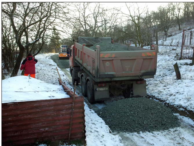
6. 10. 2012 – Oprava cesty kolem cihelny.
