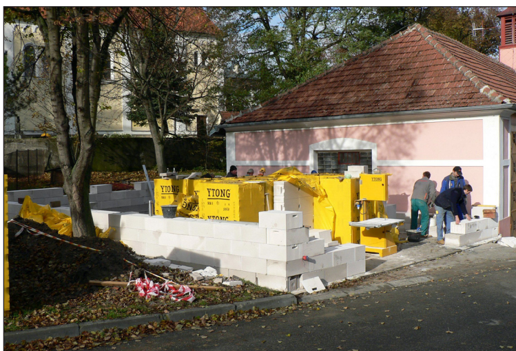
Přístavba garáže hasičárny.
