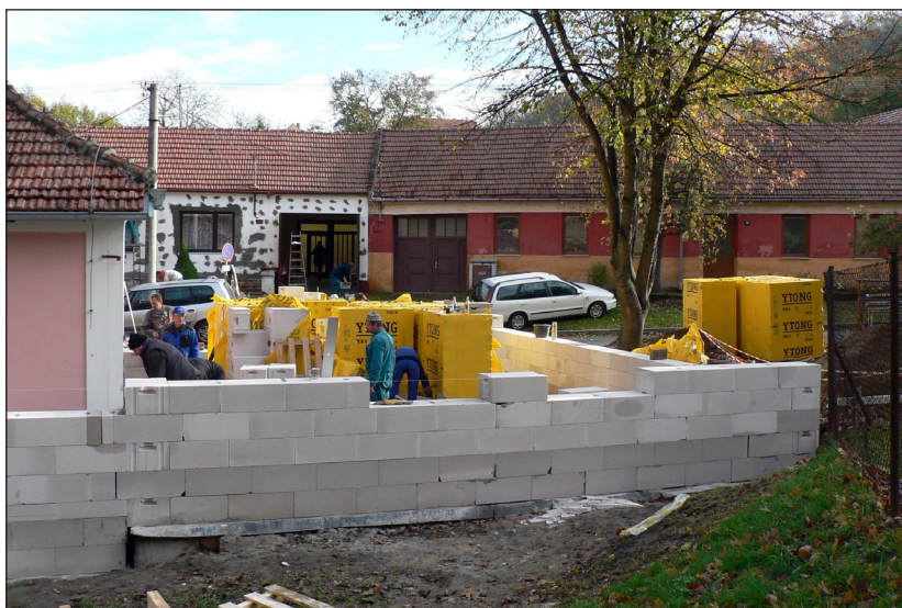
3. 11. 2012 – Zdění nové přístavby hasičárny. foto: Jiří Nevidal
