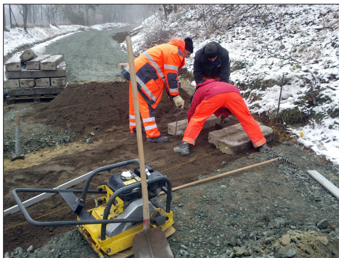
6. 10. 2012 – Oprava cesty kolem cihelny.
