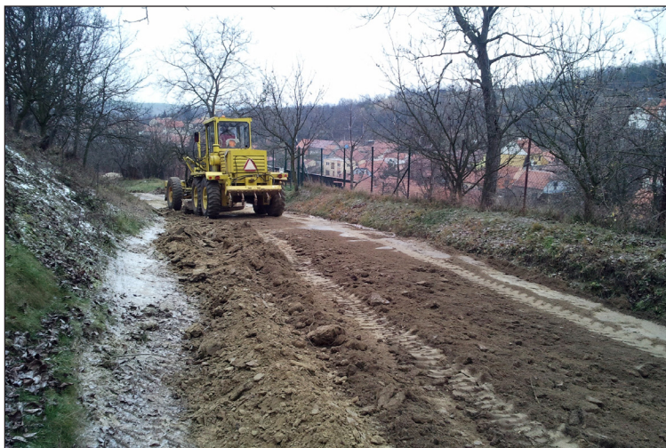
Oprava cesty kolem cihelny.
