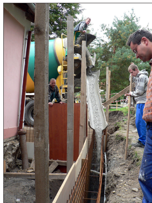
29. 9. 2012 – Betonáž základů hasičárny. foto: Jiří Nevidal
