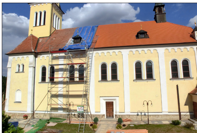
31. 7. – Oprava střechy kostela.
