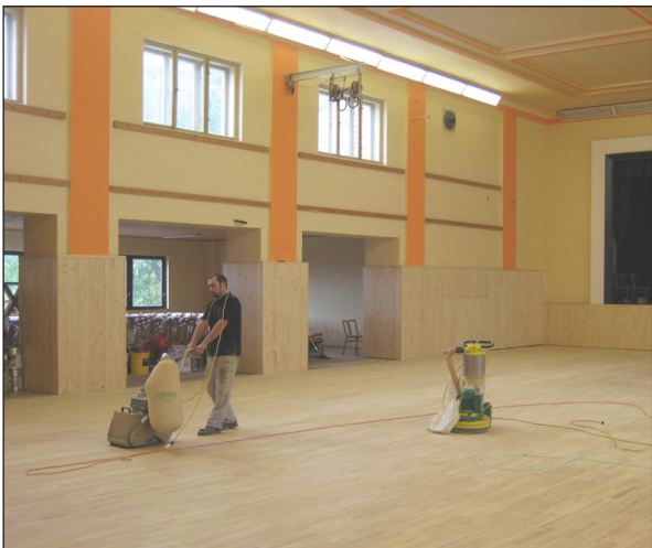
září 2010 - Oprava Sokolovny. foto: Antonín Lengál
