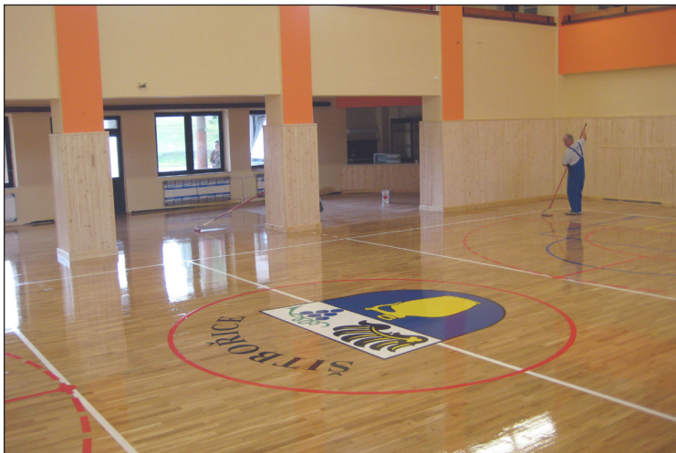
září 2010 - Oprava Sokolovny. foto: Antonín Lengál
