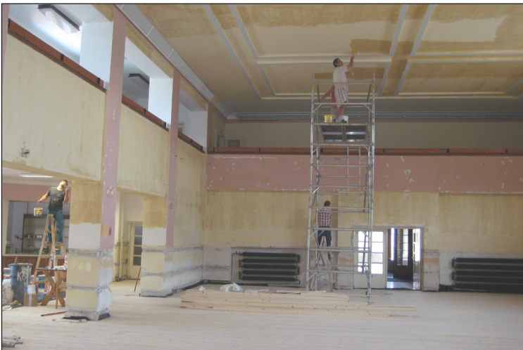
září 2010 - Oprava Sokolovny. foto: Antonín Lengál
