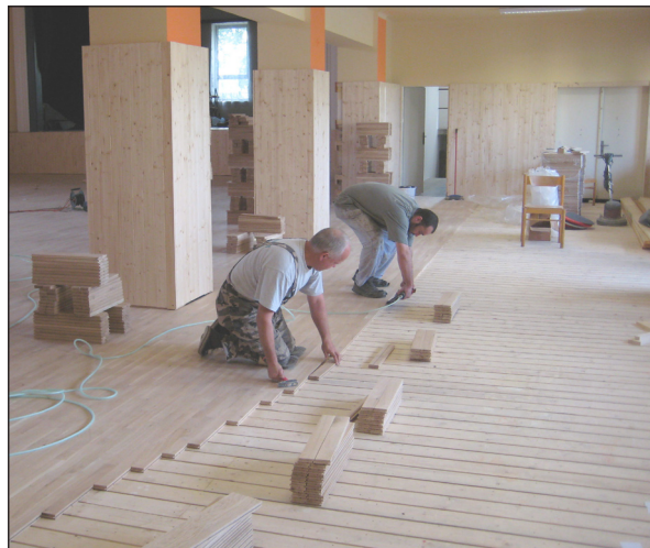
září 2010 - Oprava Sokolovny. foto: Antonín Lengál
