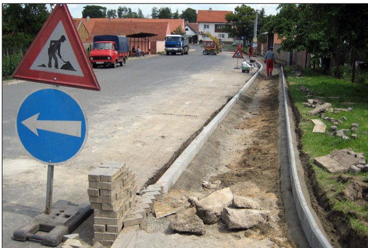
Oprava chodníku u zastávky na Nikolčické ulici.
