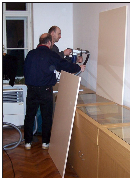
Montáž výstavních panelů
